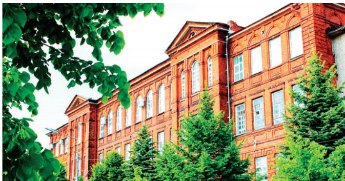
Здание Мичуринского ГАУ
