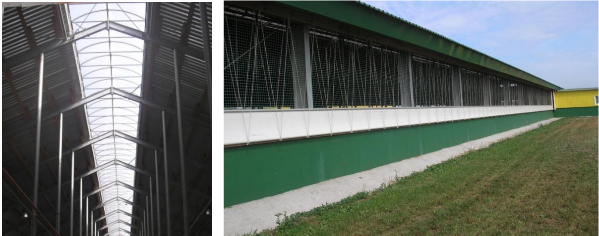
Рисунок 6 – Световой аэрационный конек в крыше и система штор на окнах поддерживает нормальный микроклимат
