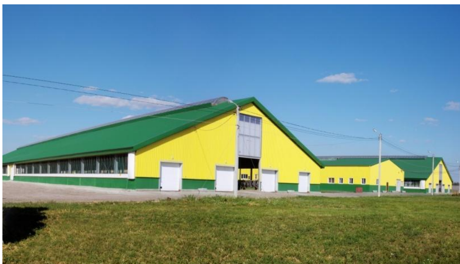
Рисунок 4 – Вид молочного комплекса со стороны доильного зала
